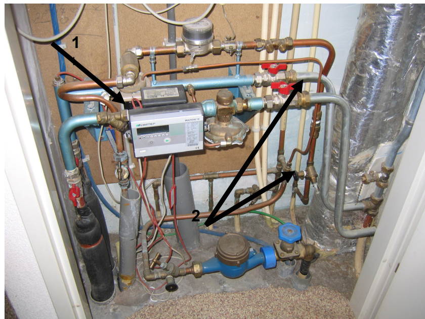
Figuur 11. Afleverset met drukgestuurde beveiliging tegen wegvallen drinkwaterduk (1) via stuurleiding drinkwater (2)
