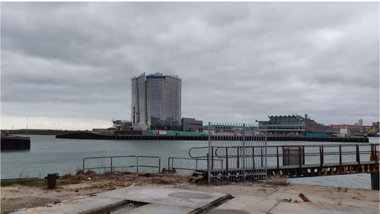
De zeezwarmtecentrale stond aan de derde haven in Scheveningen. | Foto Omroep West
