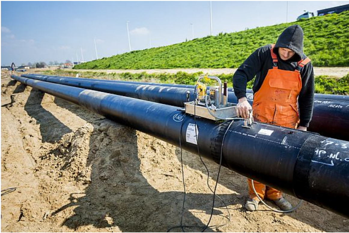
Aanleg warmtenet Nijmegen
